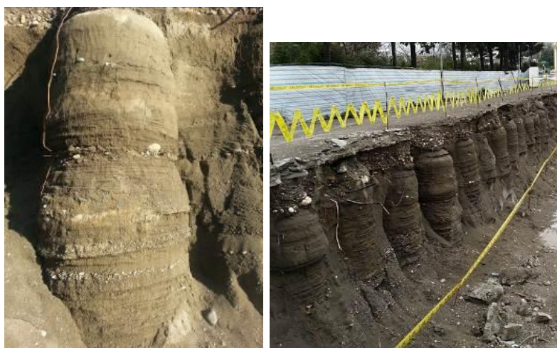
شکل ۶. برداشتن خاک اطراف ستون‌ها به‌منظور کنترل قطر
