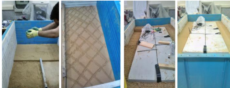
شکل ۹. خاک‌ریزی جعبه آزمایش
