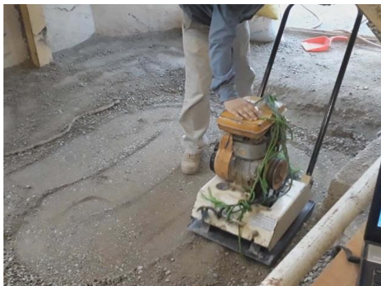
شکل ۴. تصویری از کوبیدن بستر با کمپکتور بنزینی
