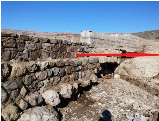
شکل ۳. هوازگی نمک در سنگ‌های استفاده شده در پایه یکی از پل‌های منطقه مورد مطالعه
