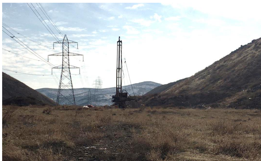
شکل ۶- عملیات حفاری در منطقه مورد مطالعه
