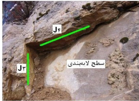
شکل ۸. سیستم درزه‌های J 3 ، J 4 و لایه‌بندی
