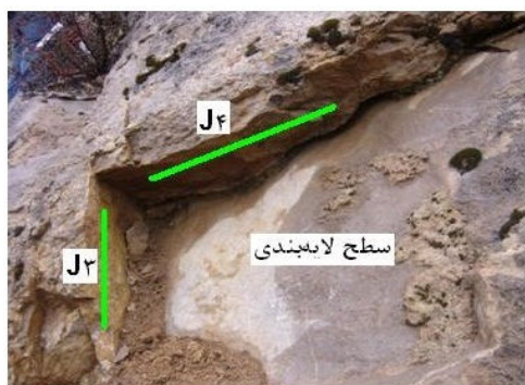
شکل ۸. سیستم درزه‌های J 3 ، J 4 و لایه‌بندی
