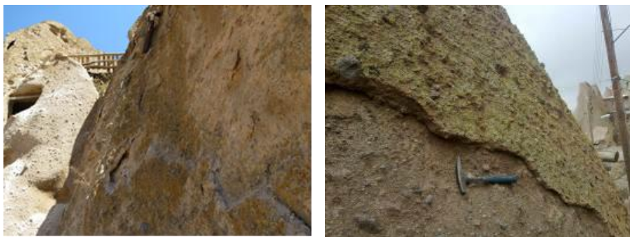
شکل ۱۳. هوازدگی و تخریب سطوح مخروط‌های سنگی کندوان
