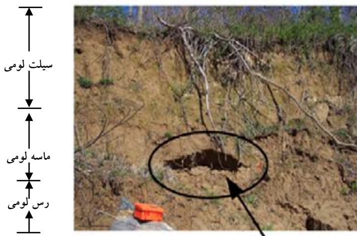
فرسایش ناشی از تراوش
