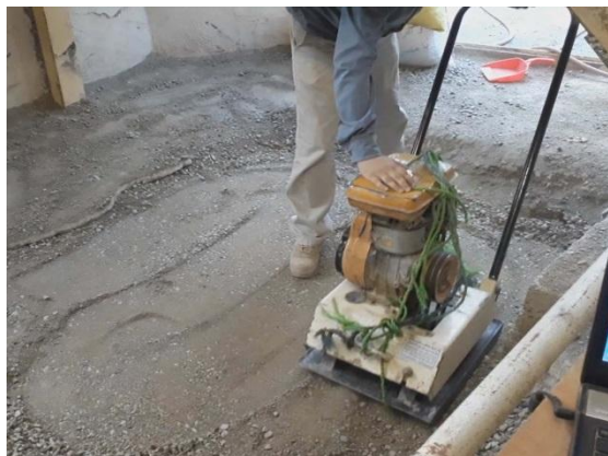
شکل ۴. تصویری از کوبیدن بستر با کمپکتور بنزینی
