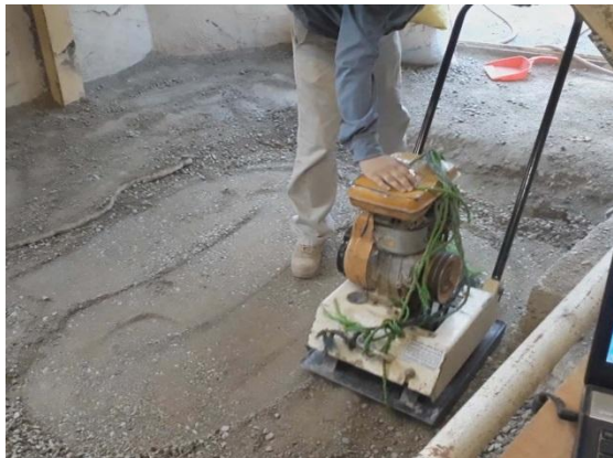
شکل ۴. تصویری از کوبیدن بستر با کمپکتور بنزینی
