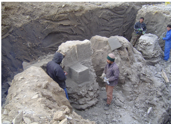
شکل ۲. ستون‌های خاک-سیمان به همراه نمونه‌های بلوکی برای گمانه‌های تزریقی T2, T3, T5 [۱۵]
