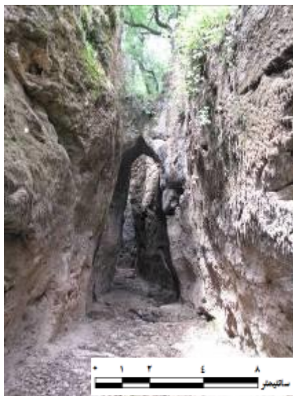
شکل (۱۲). نمای داخلی کانال باستانی پل نگین
