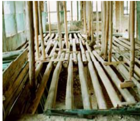
شکل (۷). سقف تیر پوش چوبی در تبریز با رعایت همپوشانی و یکپارچه سازی برای حفظ زلزله منبع: فخا، ج، تنها، ۱۳۸۵
