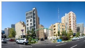
شکل (۷). ناهماهنگی مصالح ساختمان‌ها
