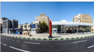
شکل (۸). ناهماهنگی بدنه ایستگاه مترو
