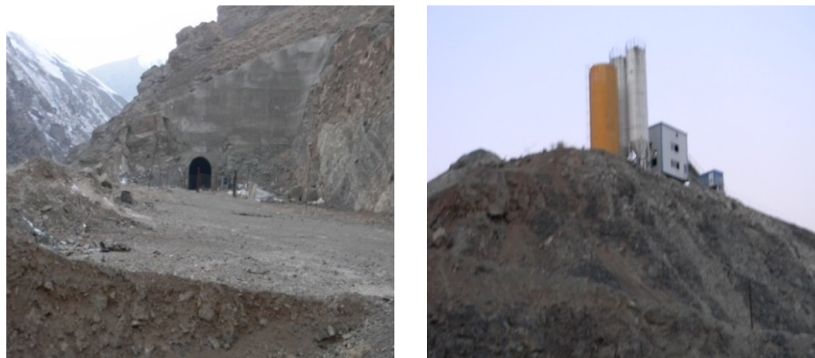
شکل (۱۱). تصاویری از عملیات ساخت تونل در مسیر
