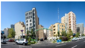
شکل (۷). ناهماهنگی مصالح ساختمان‌ها
