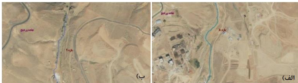
شکل (۱۰). الف) تصویر هوایی مسیر بازه ۸. ب) تصویر هوایی مسیر بازه ۹.
