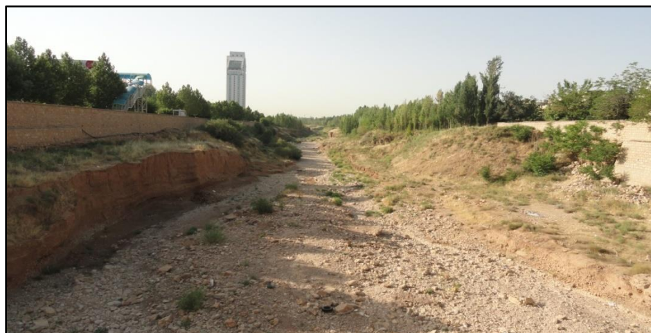
شکل ۴: ساحل‌سازی، فرسایش کناری و معبر تنگ رودخانه در بازه‌ی ۲، حوالی بلوار چمران.
