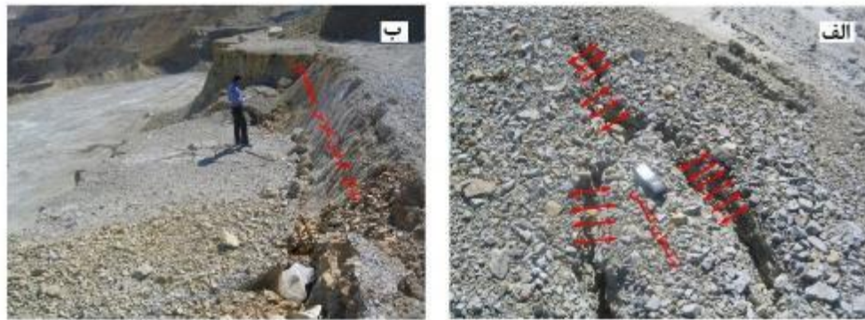
شکل ۷: الف- نمونه ترک‌ها و شکستگی‌های رخ داده در بخش شمال غربی معدن ب- لغزش شکل گرفته در محدوده فرونشستی بخش غربی دیواره معدن
